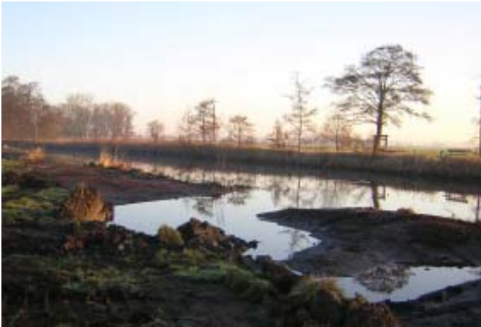
Foto 1: Teilflächen der Renaturierungsmaßnahme an der Kleinen Wümme im Bereich Waller Feldmark kurz nach Durchführung der Baumaßnahmen (Foto: bremischer Deichverband am rechten Weserufer)
