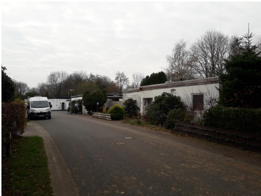
Foto 10 MP 5; Blickrichtung Süden
