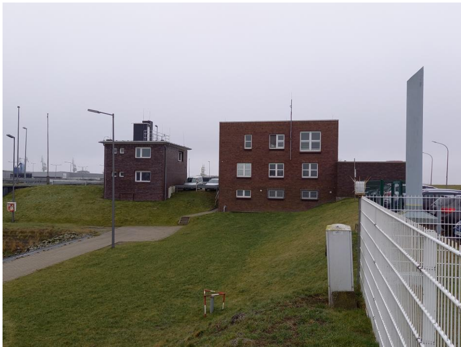
Foto 12 MP 6; Blickrichtung Süden
