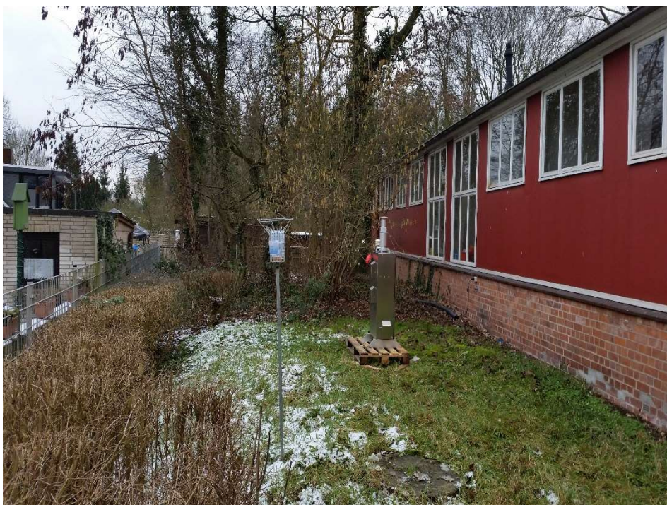
Abbildung 9A. HB 5 Grambker Heerstraße 121, 28719 Bremen; Schule an der Grambker Heerstraße; Blickrichtung Südwest
